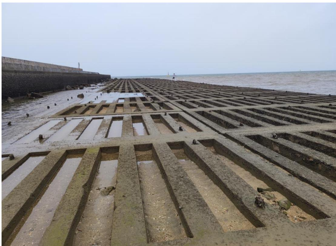
图 4.1-5 本项目护坡砼格栅结构现状照片（拍摄日期：2024 年 5 月 27 日）
