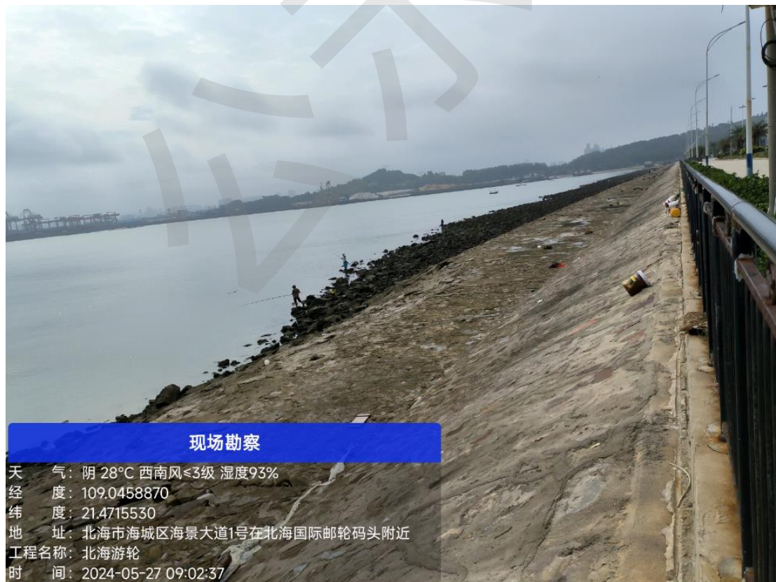
图 5.1-7 本项目护坡工程现状照片（2024 年 5 月 27 日）
