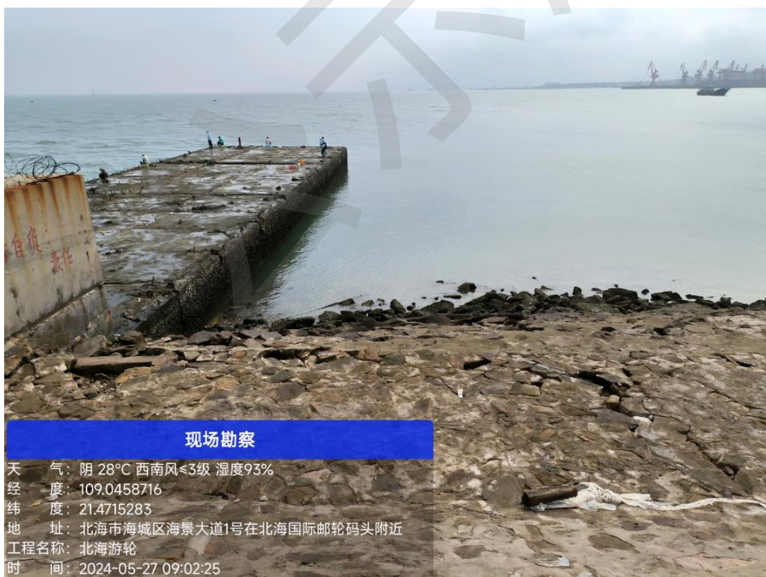
图 5.1-5 码头延伸段沉箱工程现状照片一（2024 年 5 月 27 日）
