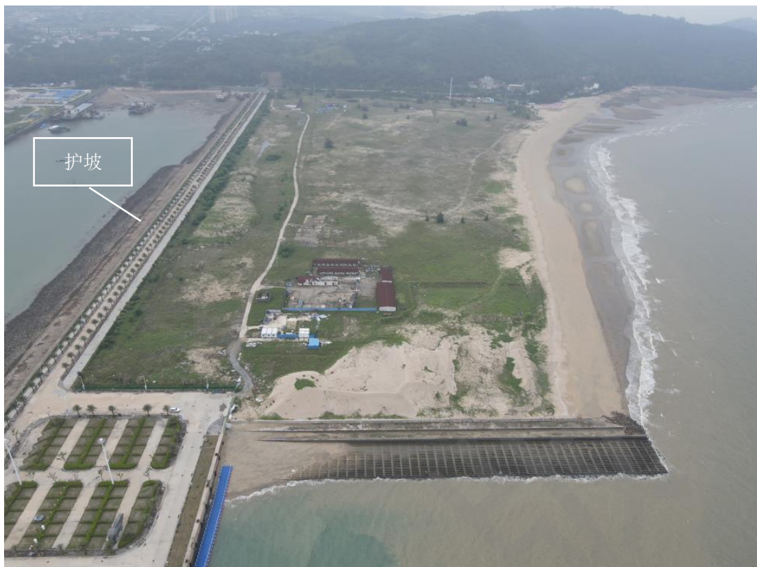
图 5.1-4 邮轮码头及本项目南段护坡现状照片（2024 年 5 月 27 日）
