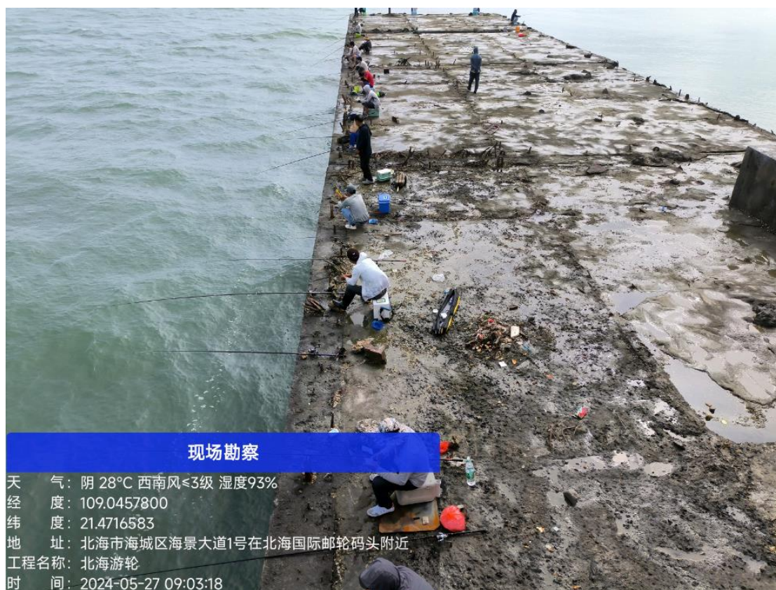
图 5.1-6 码头延伸段沉箱工程现状照片二（2024 年 5 月 27 日）
