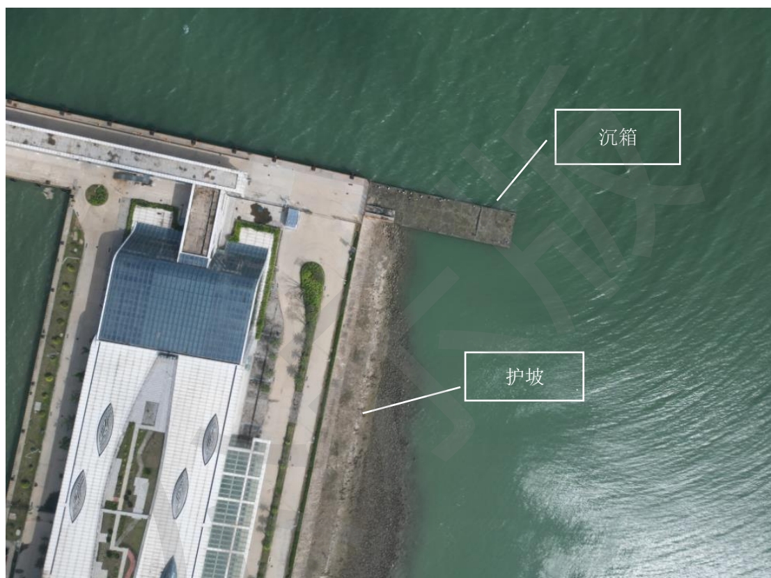
图 5.1-3 码头延伸段和北段护坡现状照片（2024 年 5 月 27 日）
