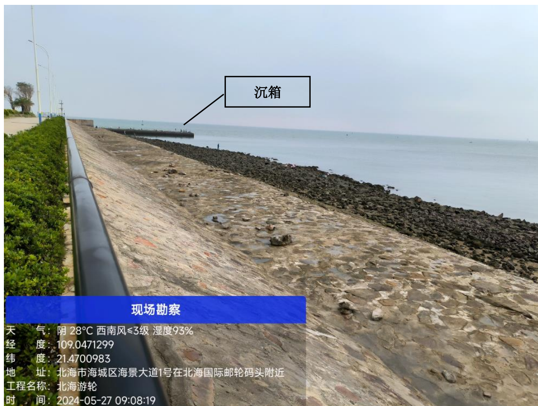
图 5.1-8 本项目沉箱和护坡工程现状照片（2024 年 5 月 27 日）
