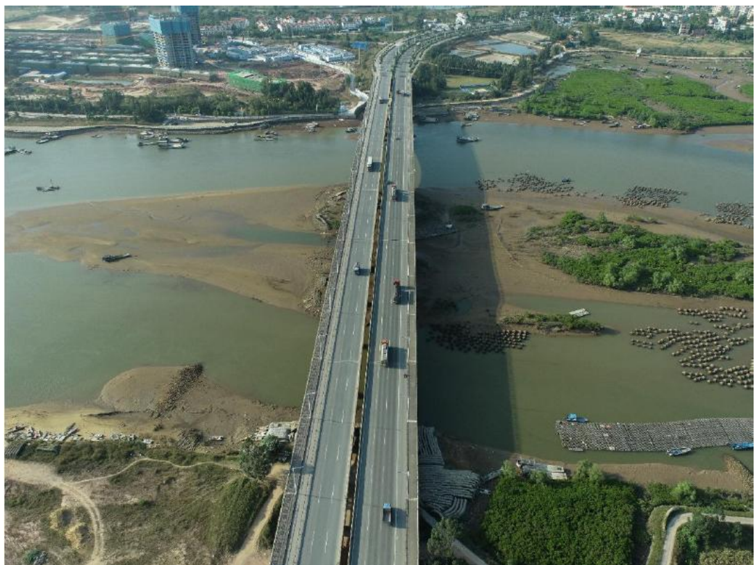
图 5.1-1 沙井钦江大桥现状图
