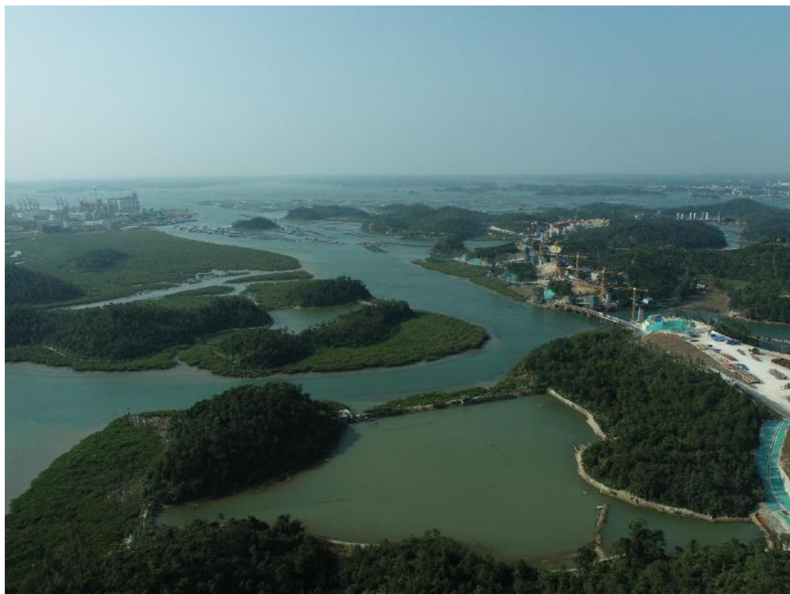
图 5.1-2 沙井钦江大桥现状图
