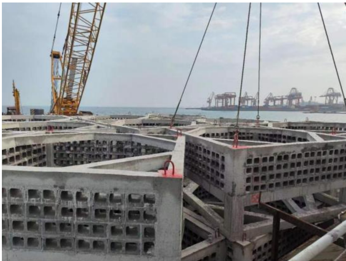
图 2.3.3-3 常规人工鱼礁装船施工图片
