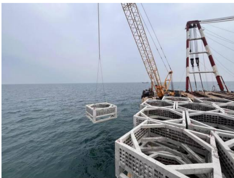
图 2.3.3-5 常规人工鱼礁海上投放施工图片
