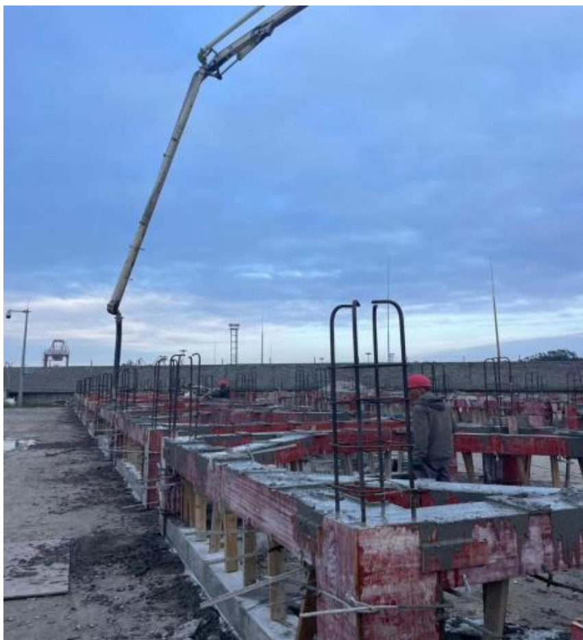
图 2.3.3-2 常规礁体预制现场照片
